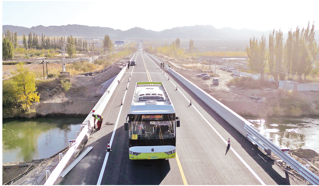
改造后的塔什店桥。
