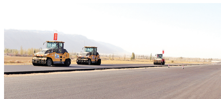
压路机压实作业。
