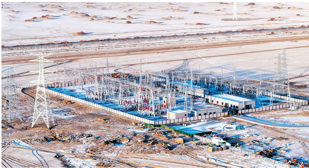
位于盐碱滩上的 220 千伏铁门关新建变电站。
