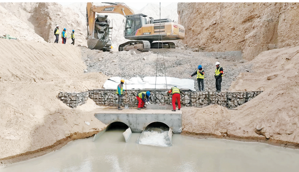
若羌县瓦石峡水库工程导(截)流施工现场。
