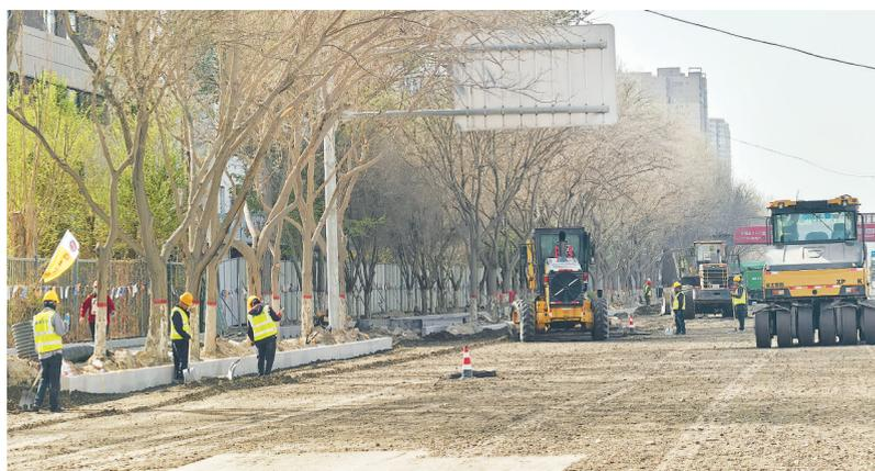
力管沟的回填;非机动车道正在进行绿化、热力管道安装及回填。
