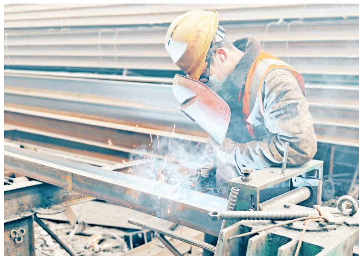
工人在焊接作业。
