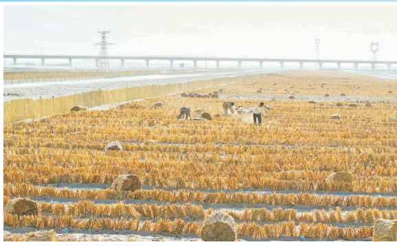
高立式沙障、草方格施工现场。 通讯员 苏波 摄
