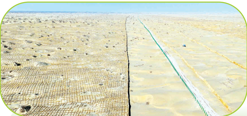
连绵起伏的沙丘被纵横数十公里的高立式沙障、草方格编织的“巨网”牢牢锁住。 通讯员 苏波 摄
