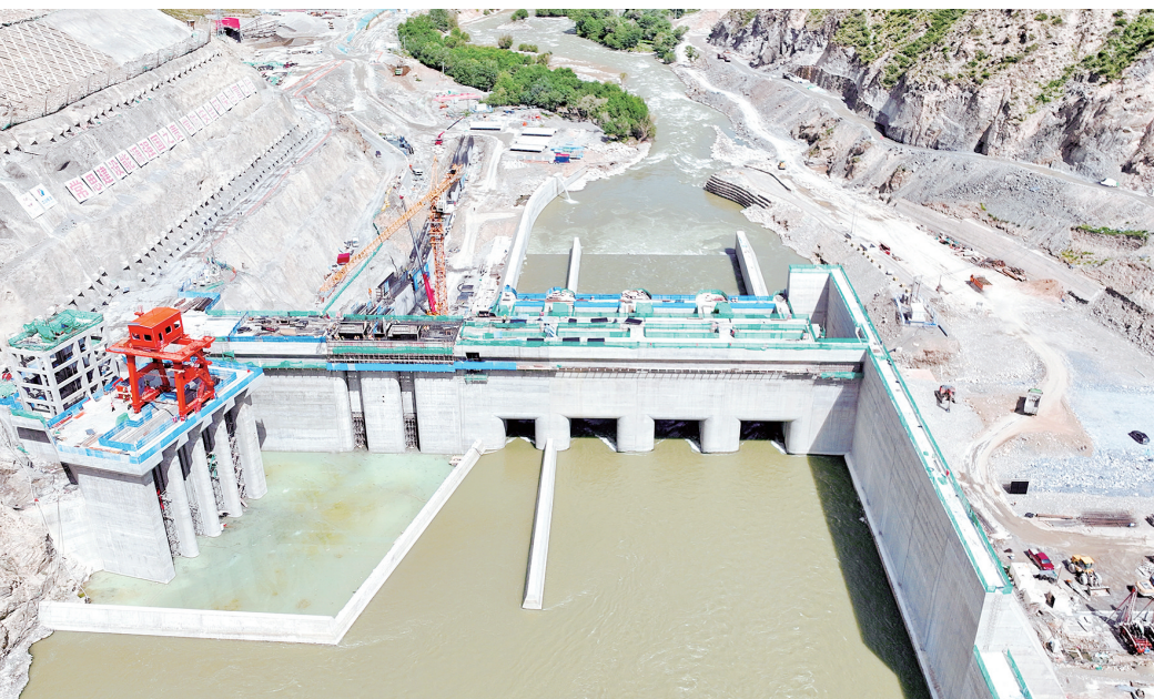
霍尔古吐水电站大坝建设现场。
