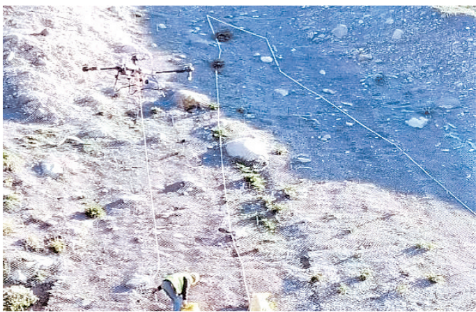
无人机在按照飞行路径向坡顶运输物资。
