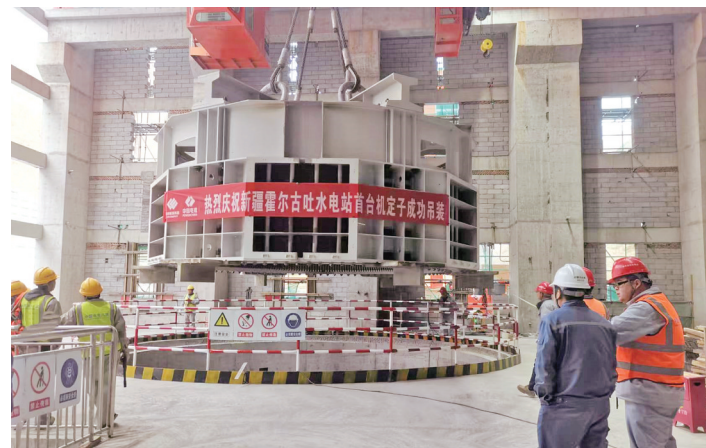
霍尔古吐水电站首台机组定子吊装现场。
