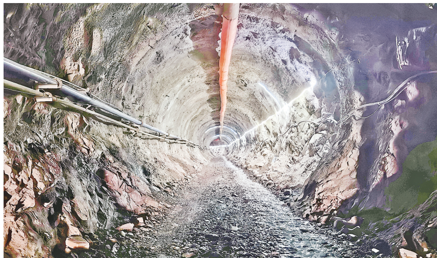
察汗乌苏生态电站引水发电洞开挖作业面。
