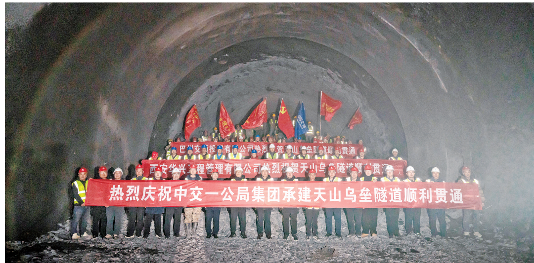
项目建设团队拉起横幅庆祝天山乌垒隧道贯通。
