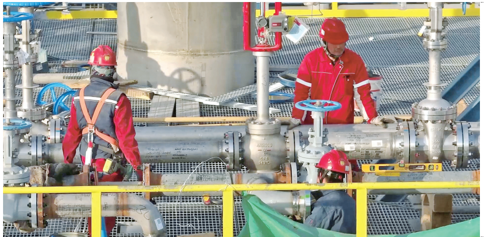
近日,工人在塔里木二期乙烯项目建设现场紧张施工。通讯员 张艺怀 摄
