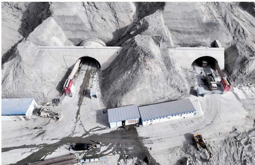
铁门关隧道出口端(3月9日摄)。
