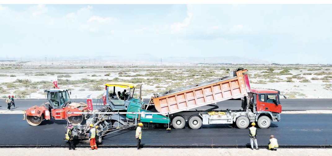
7月9日,在乌尉高速公路焉耆段,施工方对路面沥青上面层试验段进行摊铺作业。 本报记者 确·胡热 摄
